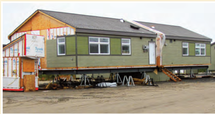
Maisons jumelées en construction, Kuujuaq, 2010.
